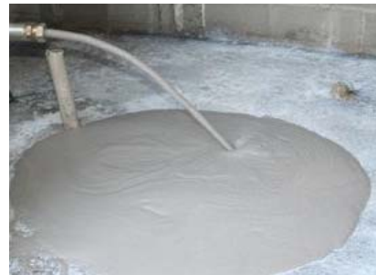
4. Bombeo y Colocación
