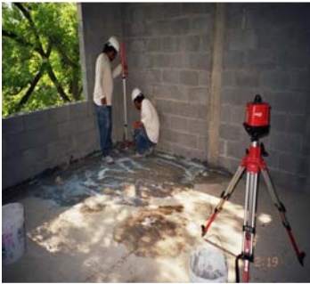
1. Nivelación y preparación de área de trabajo
